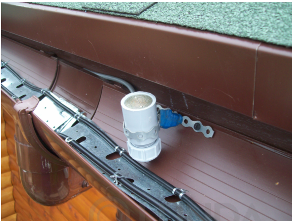
Обогреваемый карниз крыши + установка двойной монтажной ленты в подвесном жёлобе и в водосточной трубе:
